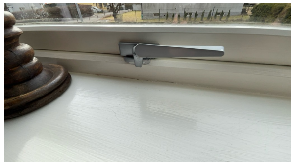
Håndtak på stuevindu tar litt imot beslag.
