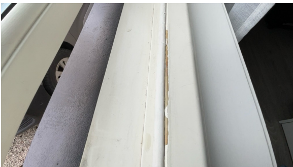
Noe malingsavskalling på soveromsvindu.
