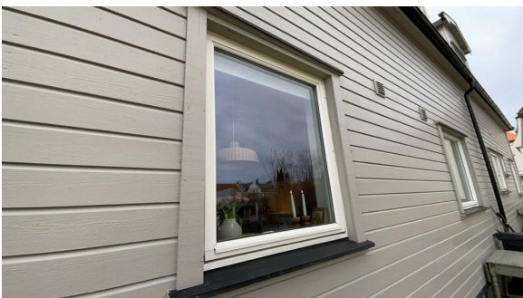
Noe malingsavskalling på soveromsvindu.
