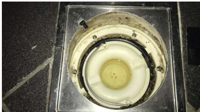
Bildet viser sluk.
