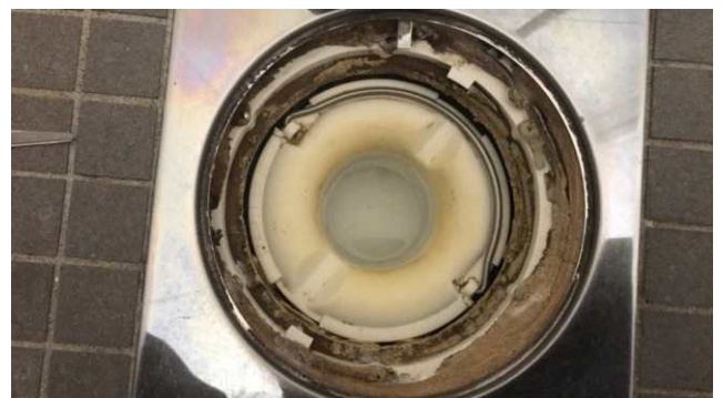
Bildet viser sluk.
