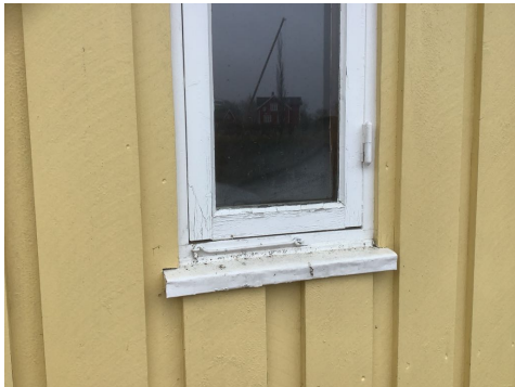
Eldre koblet vindu.
