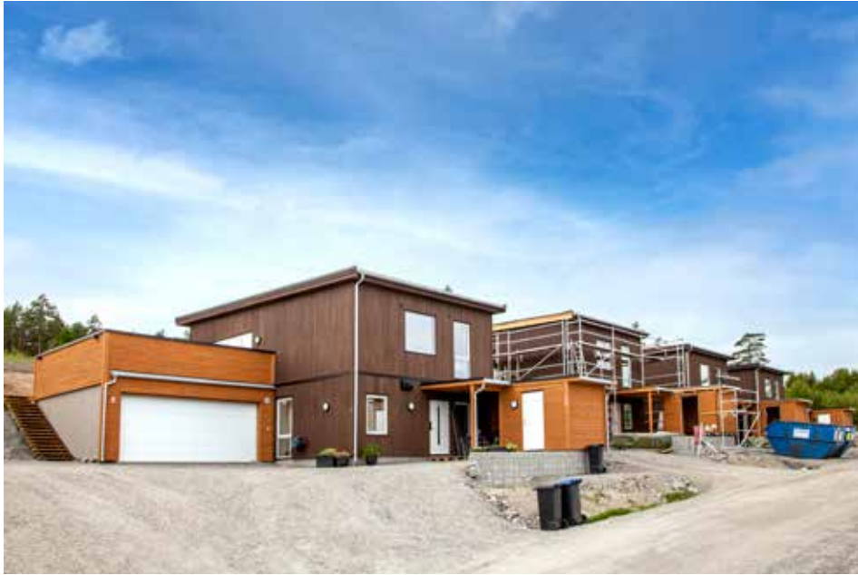
Sluttspurt på oppføring av eneboliger i kjede.
