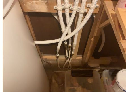
Kobberrør i grunn og rør-i-rør i bolig.
