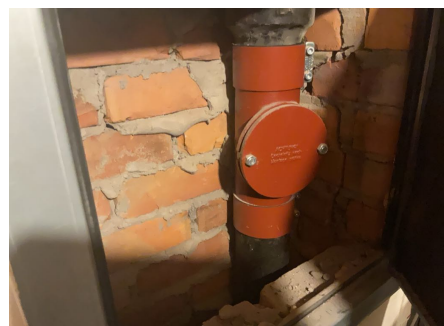
Stakeluke lokalisert bak luke i bod i kjeller.
