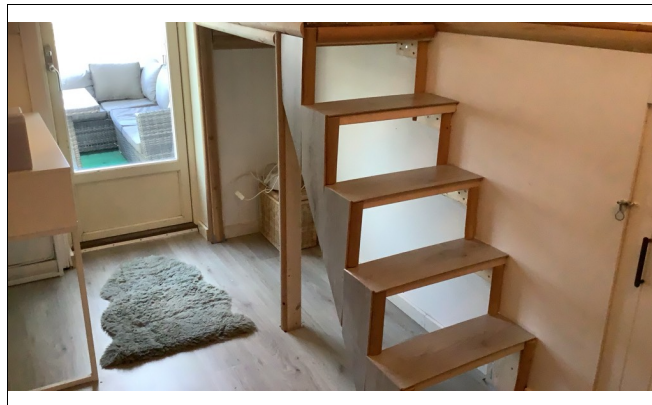
Enkel trapp uten rekkverk til rom i underetasje.
