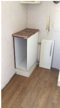
Mangler kjøkkendører. Svelling i benkeplate,
