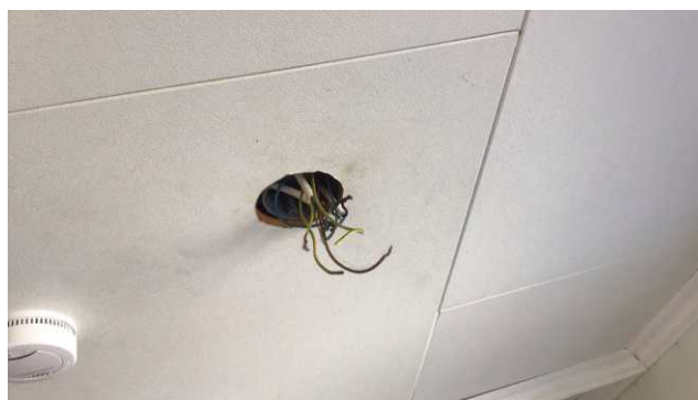
Uisolerte ledninger i takpunkt gang
