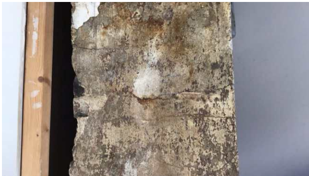
Det er påvist sprekker og/eller riss i pipe.
