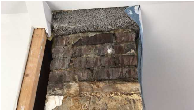
Pipe er skjøtet på loft.
