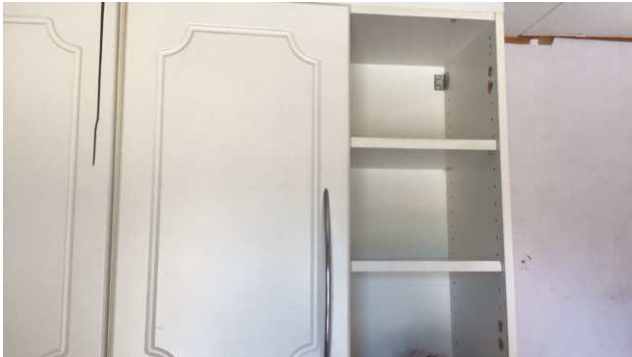
Mangler kjøkkendører. Svelling i benkeplate,
