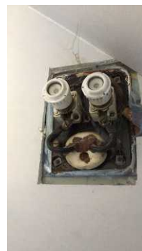
Uisolerte ledninger i takpunkt gang
