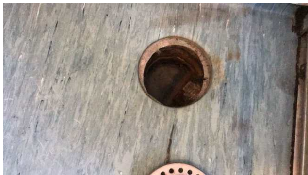
Sluk i dusj uten klemring.
