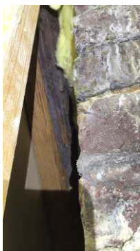
Tegn til stripet borebille bak pipe.
