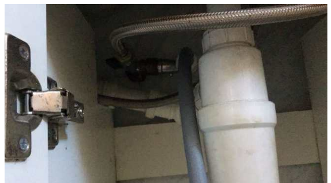
Røropplegg fra ukjent byggeår.
