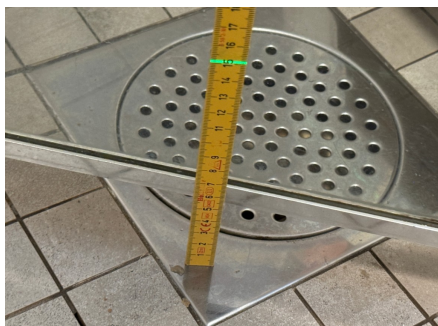
Fallforhold ca. 150 mm topp slukrist i dusjsone
