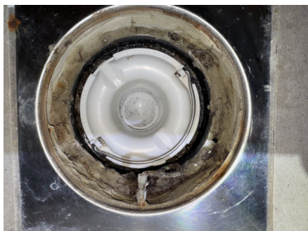
Plastsluk med klemring og synlig membran/mansjett
