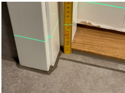
Fallforhold ca. 89 mm overkant gulv ved terskel
