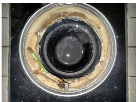
Plastsluk med klemring og synlig membran/mansjett
