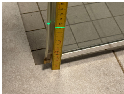
Fallforhold ca. 121 mm overkant gulv ved dusjsone
