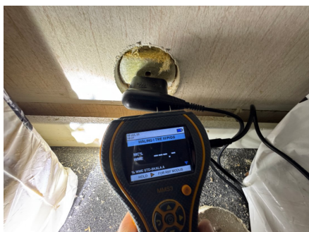
Hulltaking i tilstøtende gang
