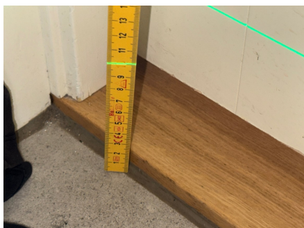
Fallforhold ca. 100 mm overkant gulv ved terskel
