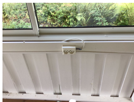
Løs kabel og feil avisolering på balkong.
