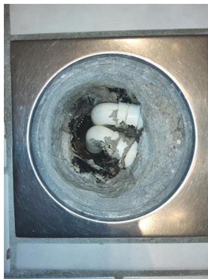
Våtrom - [Sluk vaskerom]
