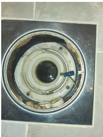
Våtrom - [Sluk bad]
