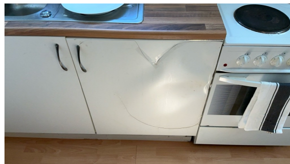
Front er ødelagt.
