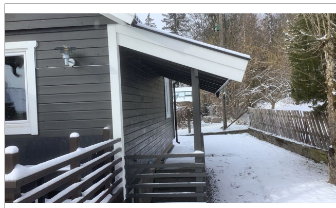
Takoverbygg ved nedgang til kjeller.
